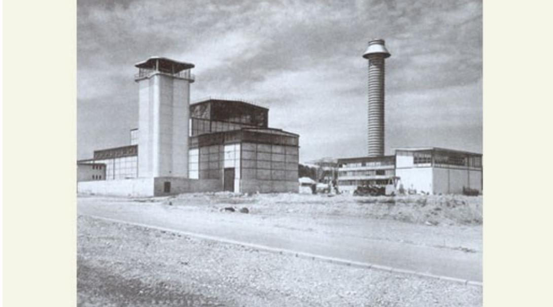
La "cheminée" de Marcoule. Photographie, 1956 © coll. part.
