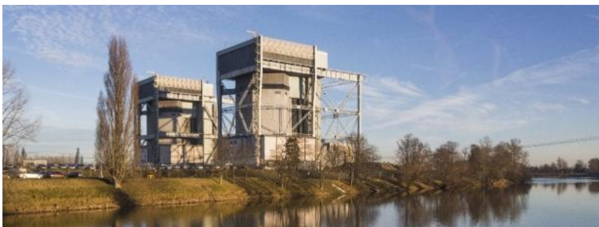
Vue de la centrale de Saint-Laurent-des-Eaux (graphite-gaz)
