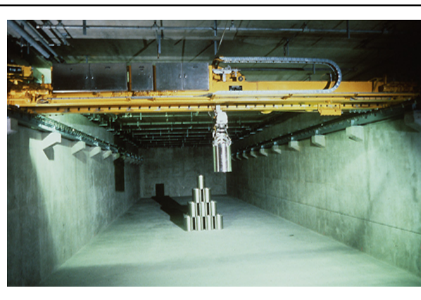
Entreposage des FEB produits par STE3
