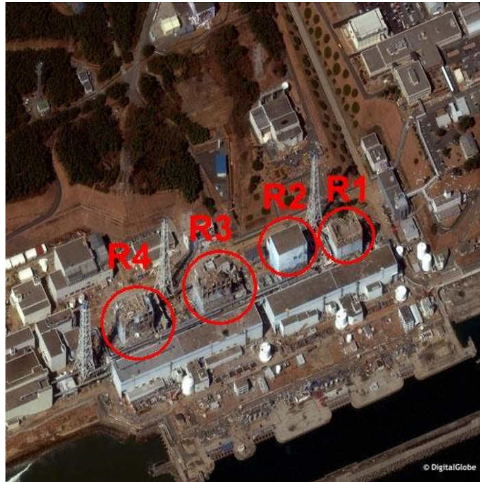
Figure 2 : Etat extérieur des réacteurs 1 à 4 le 18 mars 2011
