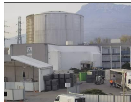
9. Retrait du bardage et désamiantage des locaux annexes
