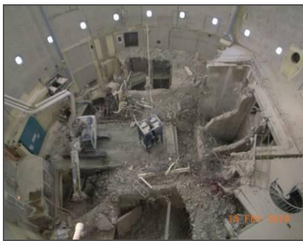
5. Démolition des structures internes avec une pelle mécanique de 30 tonnes
