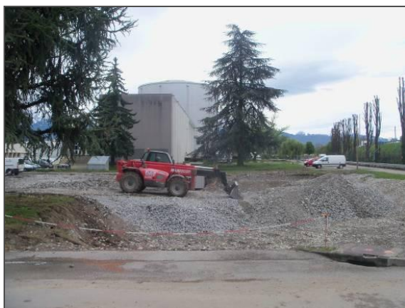
Remblaiement de la zone
