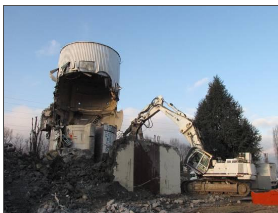
Démolition de Siloette
