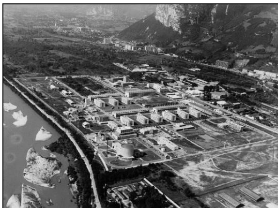
Le site du CEA Grenoble en construction
