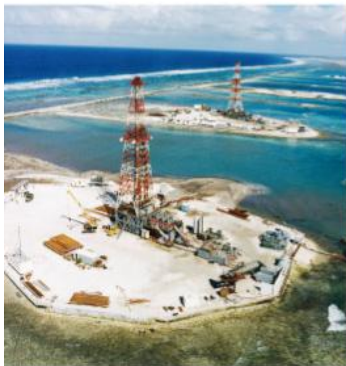
Deux forages terrestres sur deux motu en zone Sud de Mururoa.
