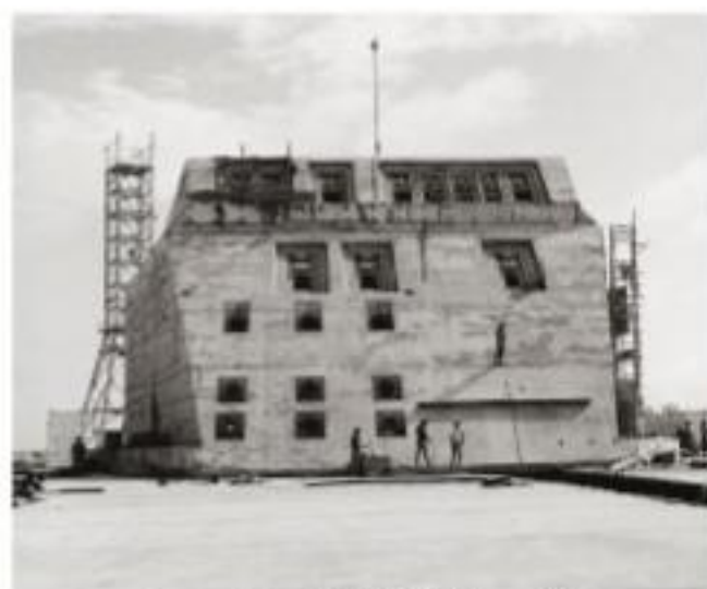
Construction du PEA DENISE en 1965.
