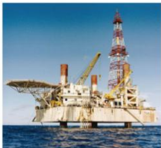
Plateforme de forage TILA.
