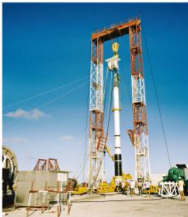
Descente dans un puits d'un conteneur à partir d'un portique.
