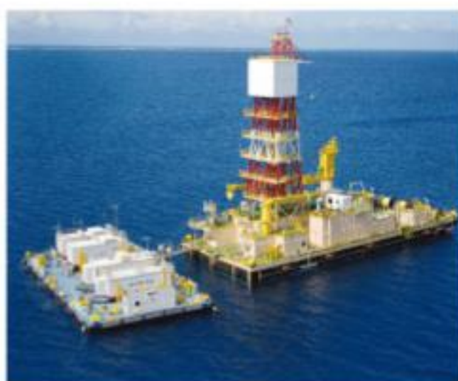
À gauche, la barge de mesures MESENGE, et à droite, la barge de manutention MANUTERE.
