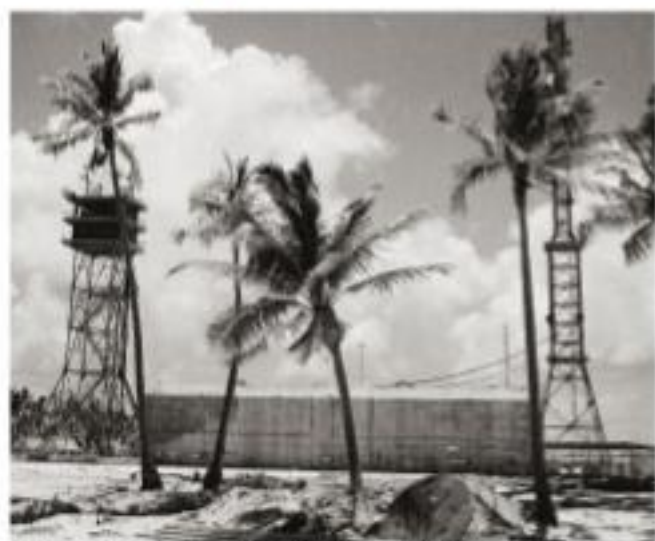
Poste de Commande de Tir (PCT) à ANÉMONE EN 1966.
