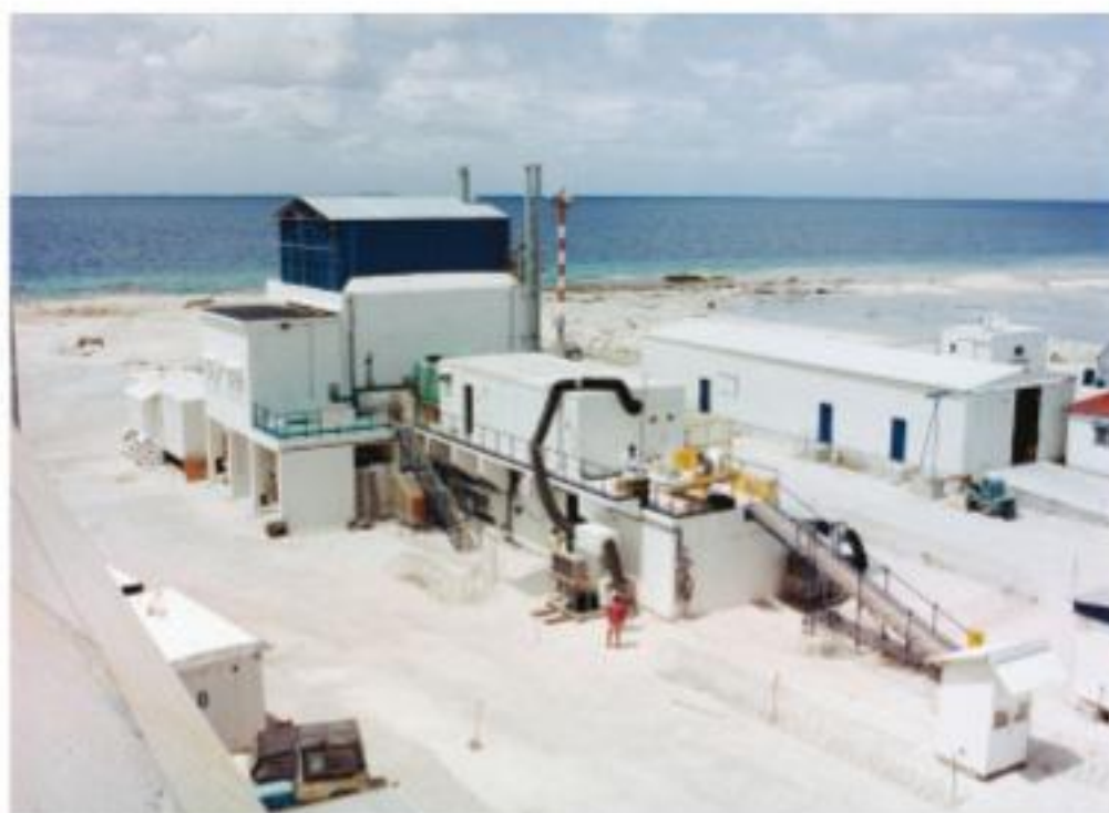
Enceinte en béton MEKNÈS en zone DENISE.
