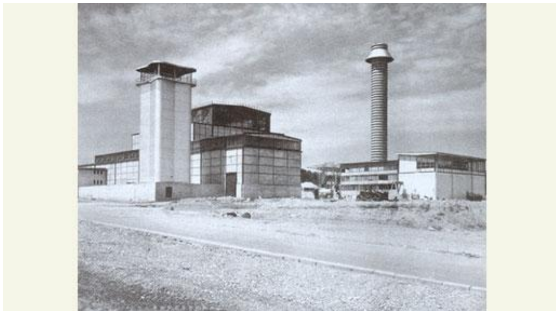
La "cheminée" de Marcoule photographie, 1956 © coll. part.
